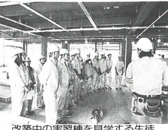
改築中の実習棟を見学する生徒
