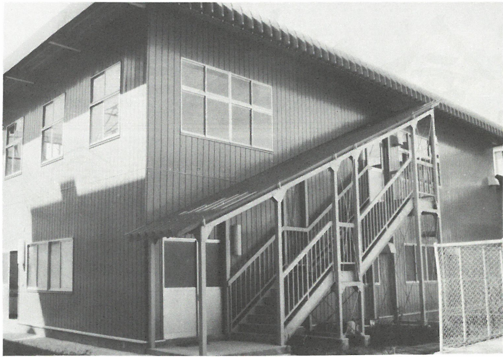
完成になった化学工学科粉砕製造工場
