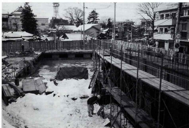
▶ 完成間近のプール工事
